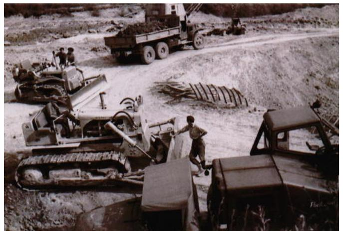
IMAGE 13 – La carrière d'extraction de l'argile située près du site sur la commune de Nuillé-le-Jalais en 1963. L'argile était extraite à la pelle mécanique, le transport s'effectuait avec 2 camion GMC récupérés de l'armée américaine
