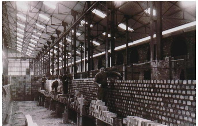
IMAGE 12 – La construction du four en 1963. Sur les murs en construction venait se poser une voûte mobile à l'aide d'un pont roulant qui permettait également le chargement du four et le défournement
