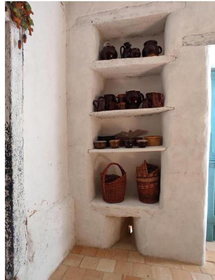
IMAGE 2 – Évier et placard fin XVIII<sup>e</sup> (Assé-le-Riboul); la pierre au sol n'est plus visible, recouverte par les tomettes
