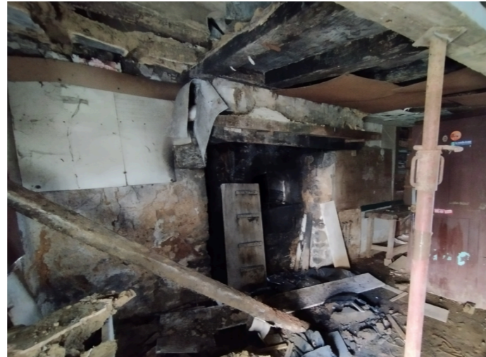
L'intérieur du fournil avant le commencement des travaux.
