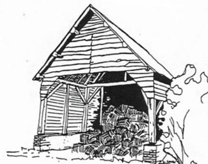
3 - Hangar: le bois, très employé dans les constructions, reposait sur un muret le protégeant de l'humidité du sol.
