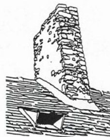
2 - Bellinois. Houteau d'aération. Cheminée décalée par rapport au faîtage.
