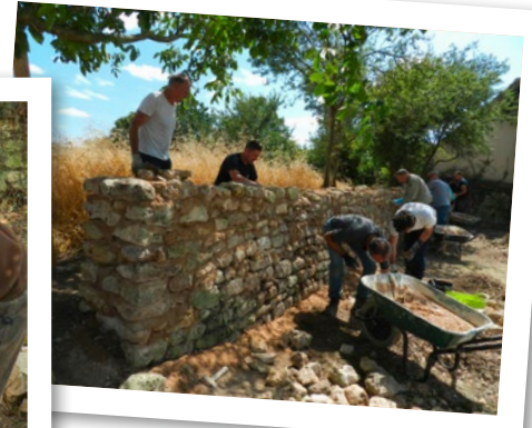
Bout du mur presque terminé
