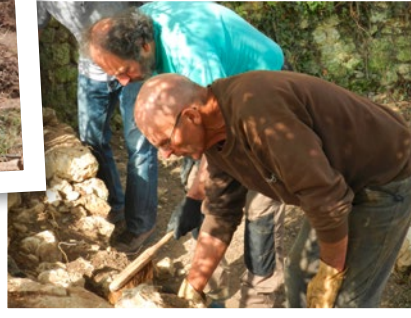
Brossage du mur
