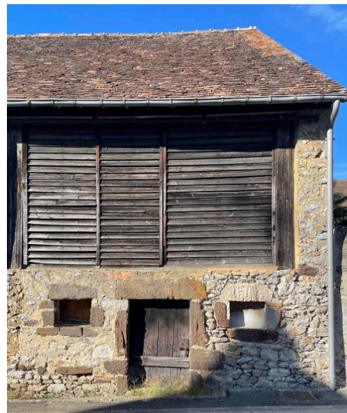
IMAGE 8 – Bâtiment du XVI e siècle, tannerie de Fresnay-sur-Sarthe
