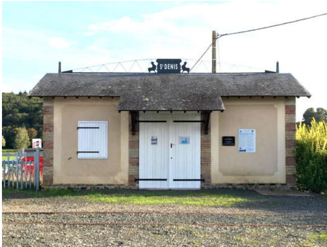
IMAGE 8 – Ancienne gare de tramway de Saint-Denis-d'Orques
