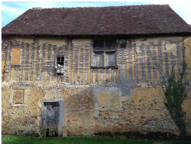
IMAGE 11 – Logis du Bordage à Briosne-les-Sables, avec étage en pans de bois, 1612
