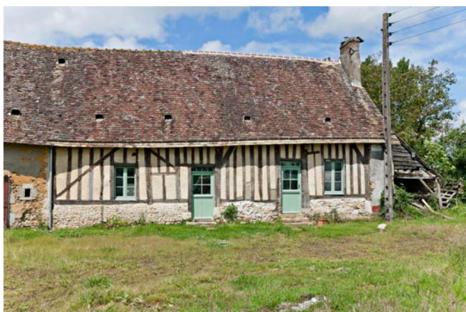
IMAGE 12 – Façade : partie droite peu après 1515-16 et son extension à gauche XVII e ou XVIII e siècle. Maison de Maulaville à Nogent-le-Bernard
