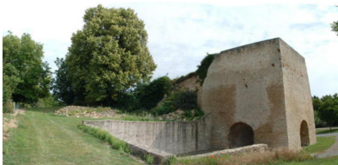
IMAGE 3 – Vue latérale du four à chaux de Tennie
