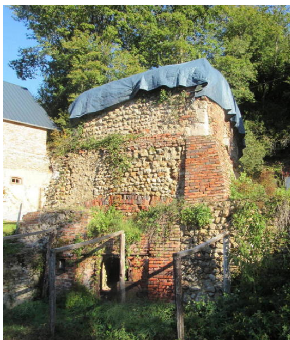
IMAGE 2 – Briqueterie de Saint-Fraimbault, commune de Saint-Georges-de-la-Couée (ce type de four à briques pouvait servir également à produire de la chaux)
