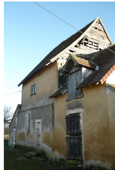
IMAGE 5 – Logis avec étage en pan de bois enduit, fin XV e ou début XVI e siècle. La Mauvaisinière à Dehault
