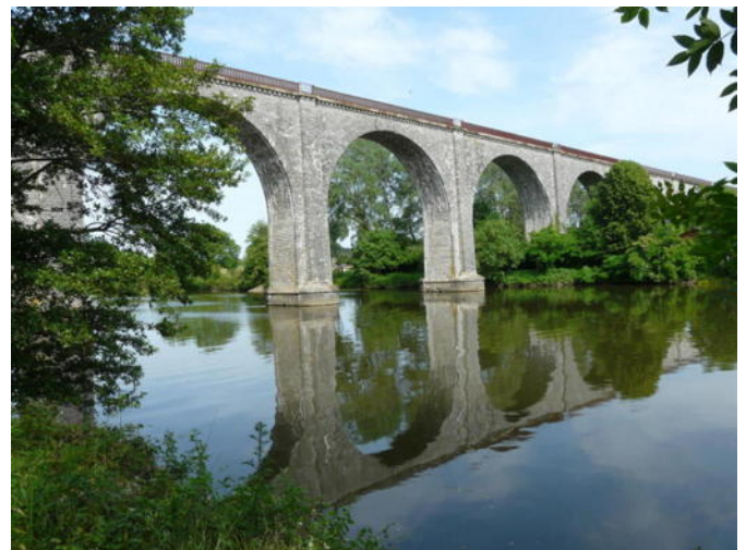
IMAGE 5 – Viaduc de Chantemesle à Sablé-sur-Sarthe
