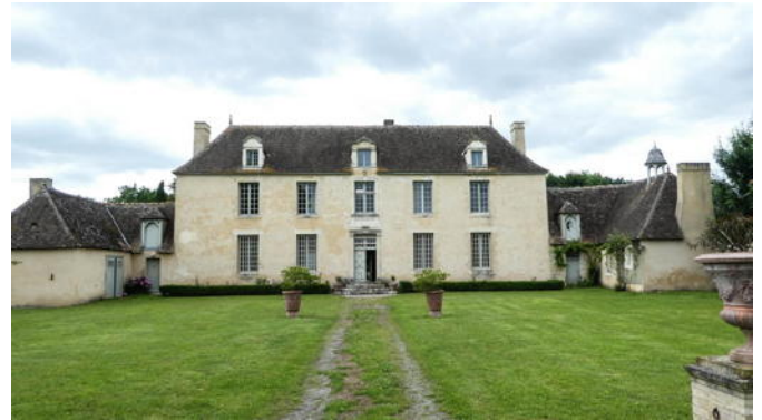
IMAGE 6 – Au logis du Plessis à Beaufay, le calcaire de Bernay a été utilisé pour une partie des encadrements ; pour le reste, notamment pour les piédroits de la plupart des fenêtres, la brique, moins coûteuse, a été préférée
