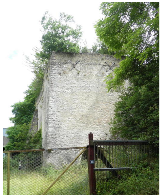
IMAGE 6 – Le four à chaux de la Chatterie, à côté de Fresnay (commune d'Assé-le-Boisne)
