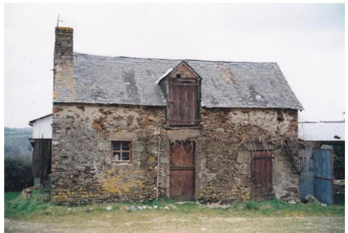
IMAGE 7 – Pour la construction de cette closerie, les matériaux ont été pris sur place : roussard, sable et schiste ; les carrières sont à proximité
