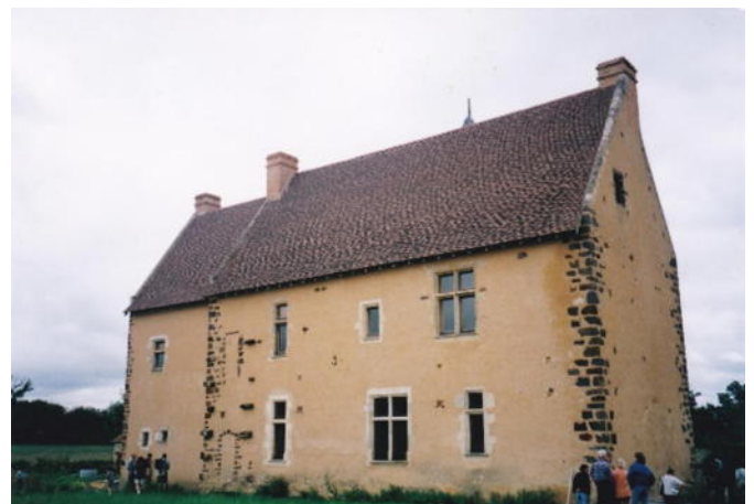
IMAGE 12 – Manoir avec des chaînages en roussards taillés; le reste de la maçonnerie est enduit
