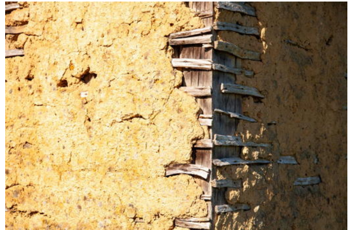
IMAGE 4 – Pan de bois recouvert d'un lattis et d'un enduit à la terre. Les Mousseries à Saint-Aubin-des-Coudrais
