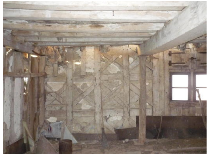
IMAGE 9 – Vue intérieure de l'étage de la Mauvaisinière à Dehault
