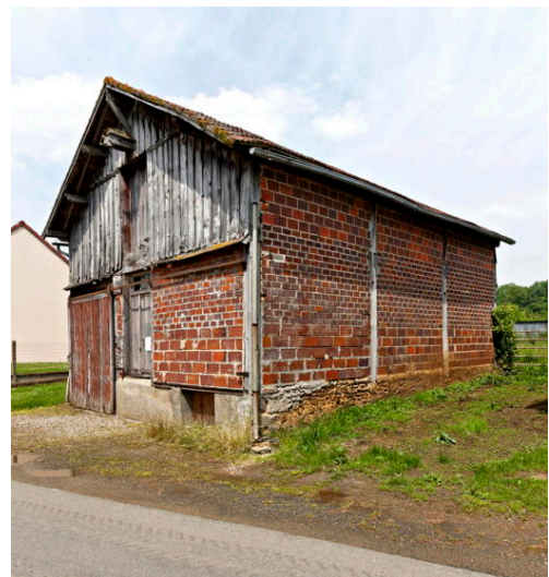
IMAGE 18 – Remise avec pans de bois hourdis de briques creuses et pleines, début du xx e siècle, rue du Lavoir à Nogent-le-Bernard
