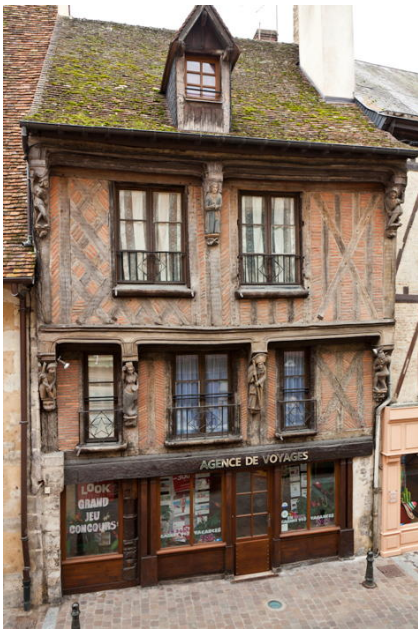
IMAGE 6 – Maison n° 10 rue Carnot à La Ferté-Bernard. Le hourdis de briques n'est pas traditionnel en Sarthe, il a probablement remplacé le torchis au moment de la restauration
