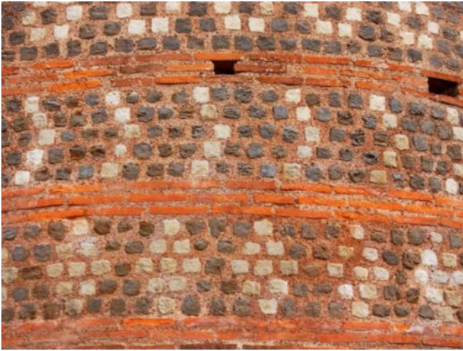
IMAGE 9 – Le grès roussard, la brique et le mortier rose donnent à la muraille gallo-romaine du Mans sa couleur caractéristique
