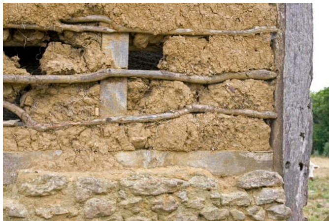
IMAGE 16 – Détail du pan de bois de la grange de la Pichinière
