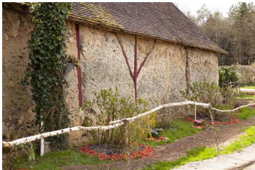
Vibraye, la Fontaine de Guette-Loup, façade arrière de la maison et ses renforts en bois. Cl. CEMJIKA-Perche Sarthois, 2018.
