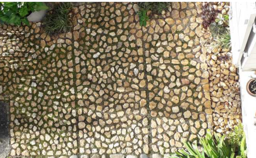
Vue d'ensemble de la terrasse
