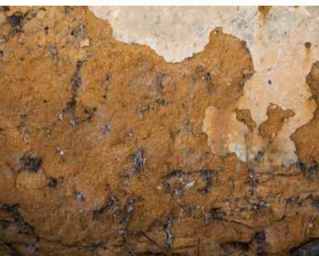
Ussardière, détail du mur en bauge et de ses vestiges d'enduit à la chaux. Cl. CEMJKA-Perche Sarthois, 2016.
