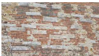
Maçonnerie composée de blocs de grès éocène intercalés entre des briques
