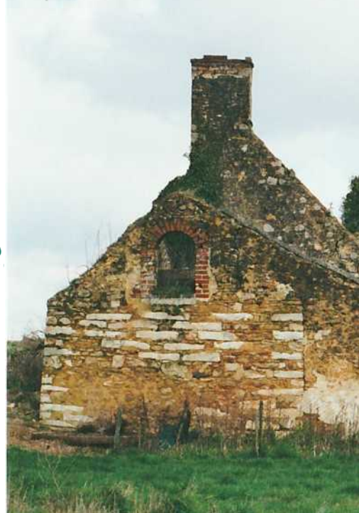
Blocs de grès éocène dans un mur pignon à Sargé
