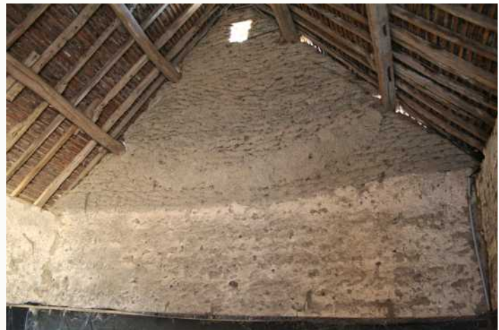
Préval, les Pâtis, vue intérieure de la grange avec détail du montage par alignement de mottes. Cl. Perche Sarthois, 2006.
