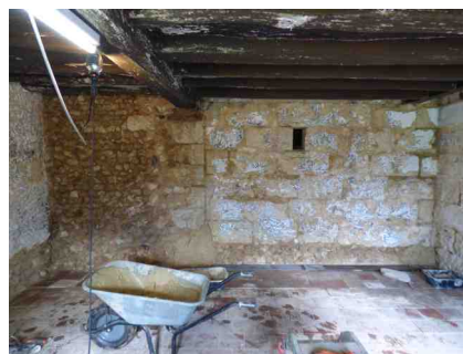
Maison neuve L'extension empiète sur la grange construite en moellons de silex. Les parpaings de tuffeau s'accolent au chaînage d'angle de la grange
