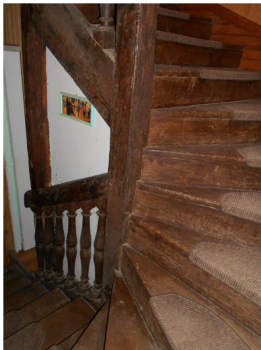
L'escalier actuel en bois, à balustres tournées, demi-tournant, à quatre volées de marches.
