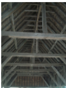
René - charpente des halles - charpente à chevrons formant fermes
