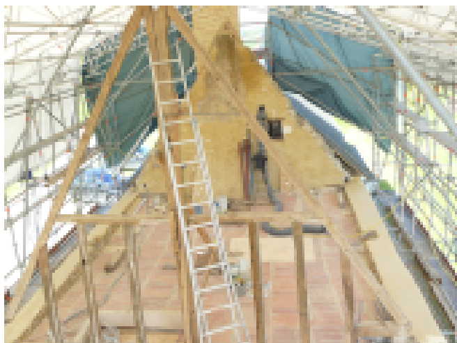
Réfection totale de la toiture...sous un parapluie
