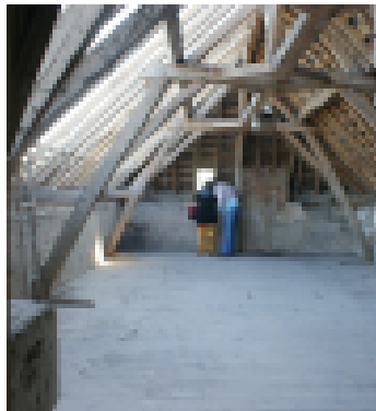
Le Grand-Lucé - charpente à « entrait retroussé » et surcroît des murs
