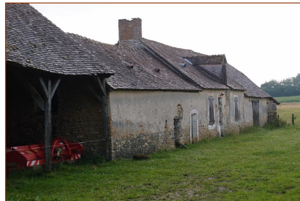
Ancienne ferme à Ballon, construite en calcaire local recouvert d'un enduit à la chaux. Les ouvertures sont cadrées par un badigeon blanc.
