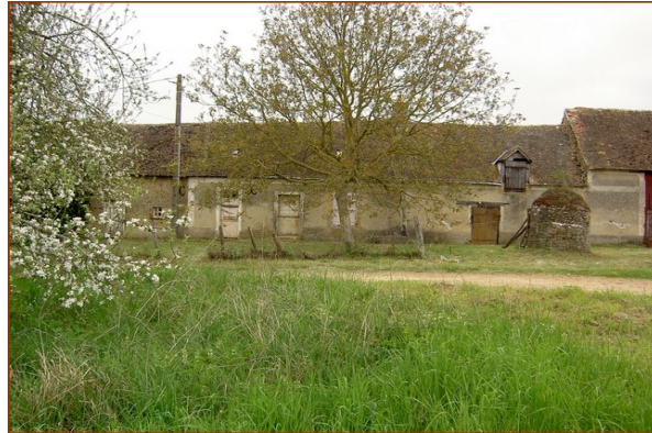
Ancienne longère typique du Nord de la Sarthe
