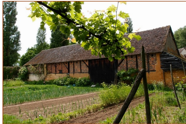
Grange à pans de bois hourdés de briques, au nord du Mans
