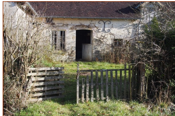
Maison à Saint-Rigomer-des-Bois, près d'Alençon: encadrements en granite, maçonnerie de pierres calcaires enduite à la chaux.
