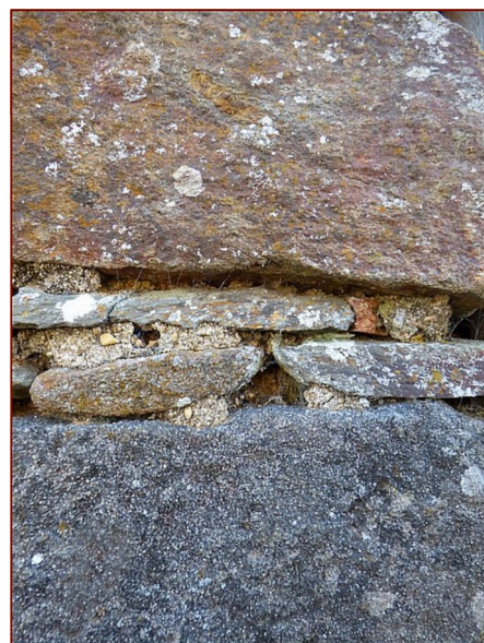
Mur maçonné d'une maison à Bure
