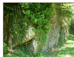
Pignon de la gare
