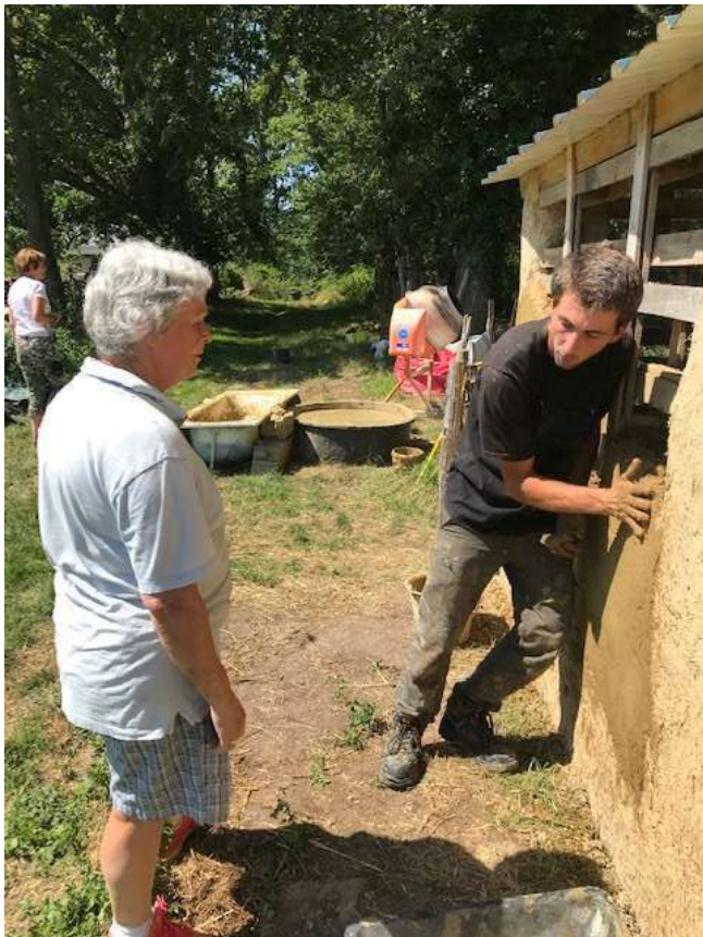
Application de torchis sur structure
