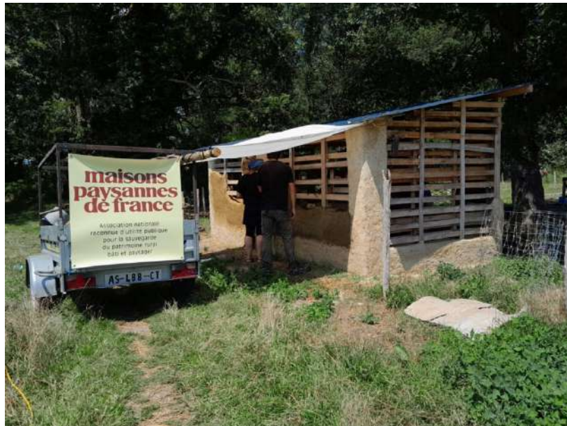
Aménagement du chantier
