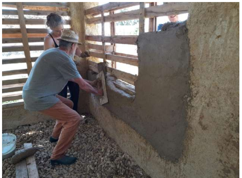
Application de torchis sur structure
