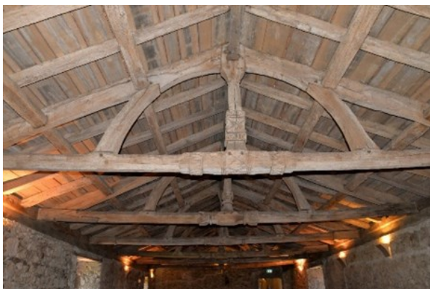
Vue d'ensemble de la charpente.
