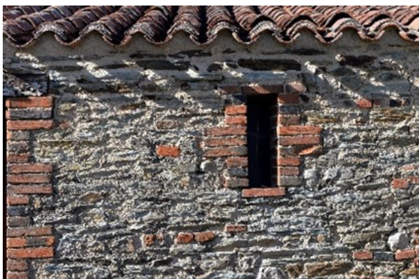
Détail d'un mur.
