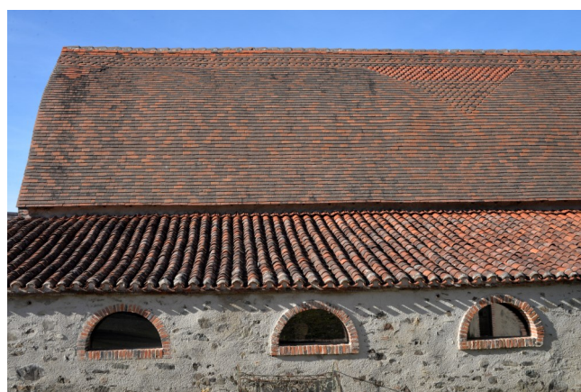
Une charpente terminée.
