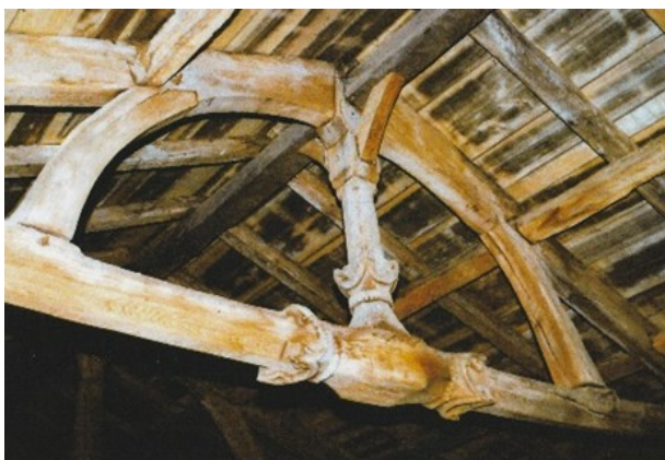
Détail d'une des fermes (Photo : Jacques Chauvin).
