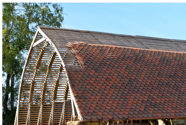
La charpente en cours de construction.
