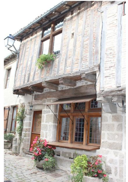
Maisons de type gothique dont le rez-de-chaussée comporte parfois des boutiques fermées par des volets de bois. L'encorbellement permet de construire plusieurs étages: ainsi chaque étage protège l'étage inférieur des eaux de pluie et permet un gain de place.
